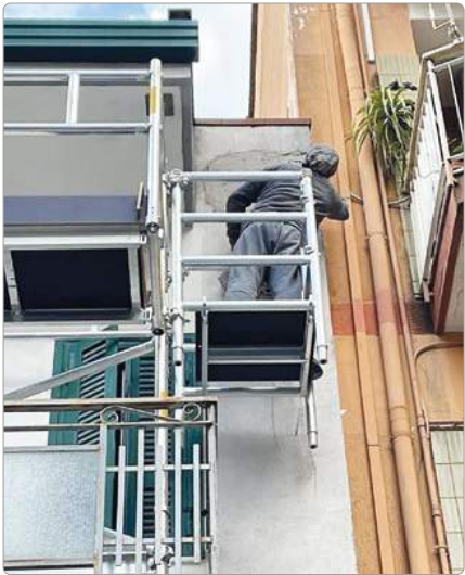
Estructura apuntalada y con contrapeso.
